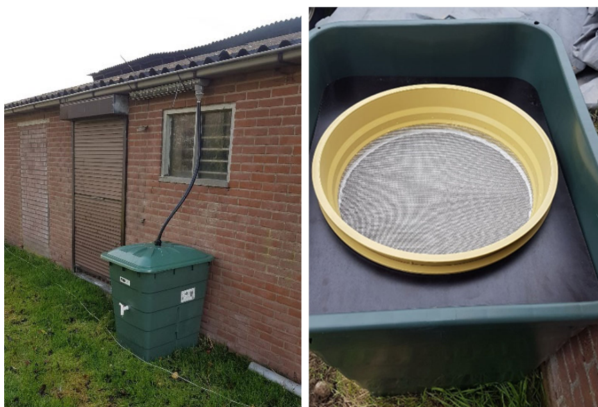
Figuur 11: Regenwateropvangsysteem op meetlocatie Hoevelaken-2
