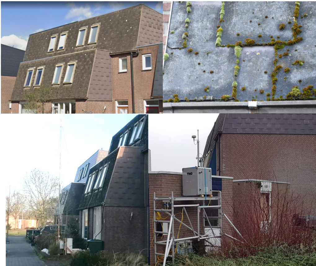
Figuur B16. Overzichtfoto's van de meetlocatie Lelystad-2 met de asbestleien gevel en dakbekleding (boven), de windrichting-aangestuurde meetopstellingen boven- en benedenwinds van de woning (onder) en de uitspoelingsopstelling (linksonder).
