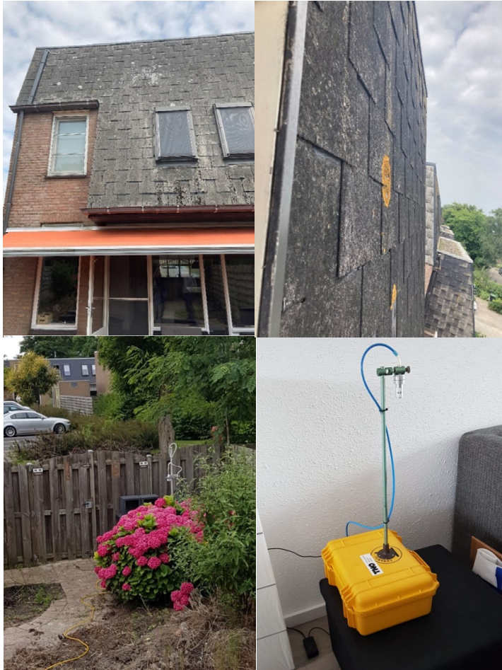
Figuur B13. Overzichtfoto's van de meetlocatie Lelystad-1 met de asbestleien gevel en dakbekleding (boven), de buitenluchtmeting in de achtertuin (linksonder) en de binnenmeting in de woning (rechtsonder)
